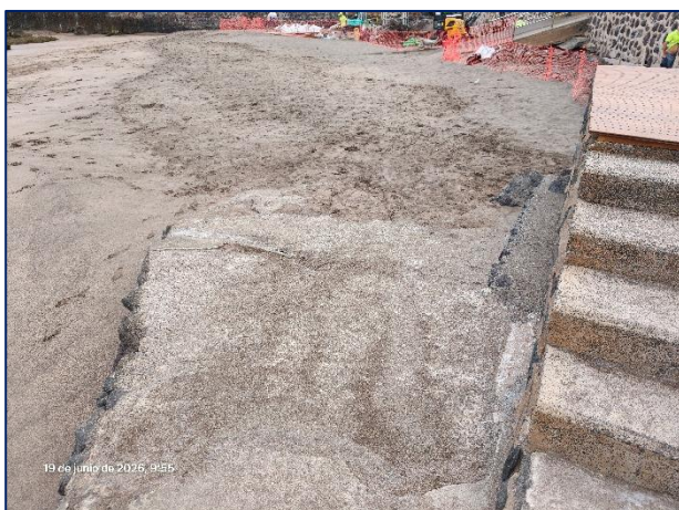
Rampa, desnivel y escaleras.
