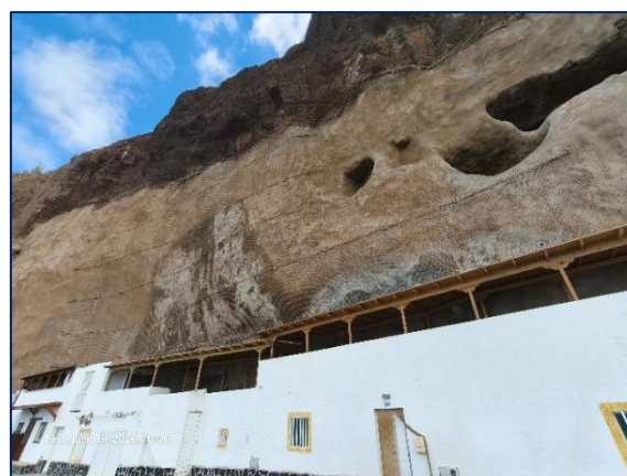
Actuaciones de estabilización del talud.
