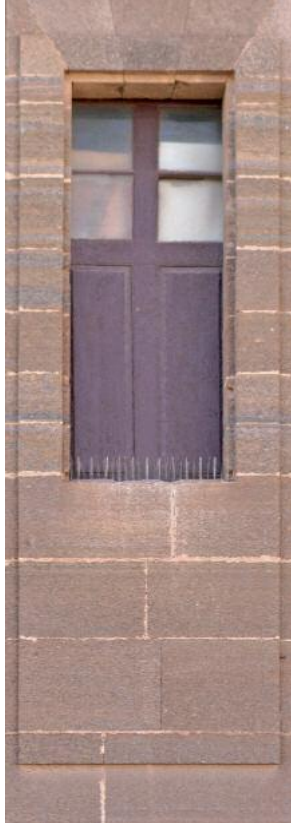
Fig. 39. Ventana de la parte media de la torre.
