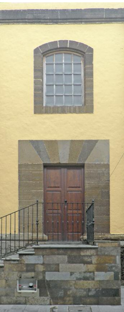
Fig. 13. Puerta de la sacristía.
