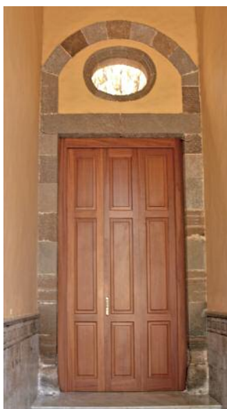
Fig. 164. Puerta de acceso a las Casas Consistoriales.
