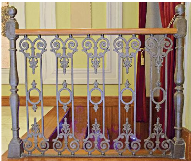
Fig. 222. Verja de las escaleras.
