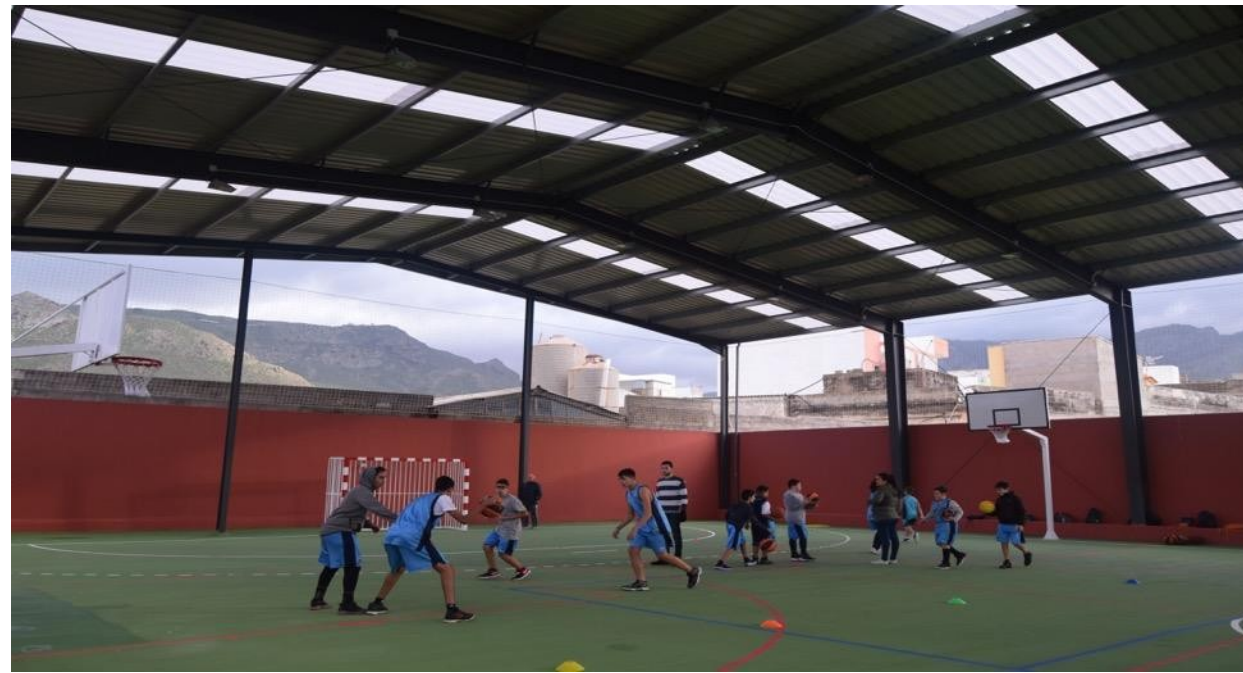
Imagen 5. Remodelación de la cancha deportiva de Piso Firme.
