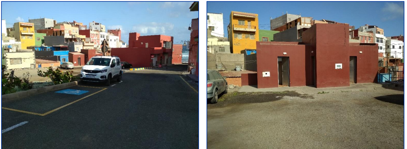
Ilustración 10. Instalaciones para PMR (se observan uno de los estacionamientos y el aseo –el del centro de los tres-).
